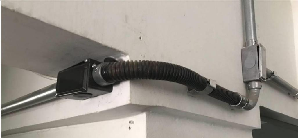
As caixas serão aparentes externas à alvenaria e no concreto, para interruptores, tomadas, luminárias e caixas de passagem, deverão ser de PVC, de fabricação Tigre ou similar com dimensões de 100x100x80 mm, sendo retangulares, octavadas e sextavadas.
