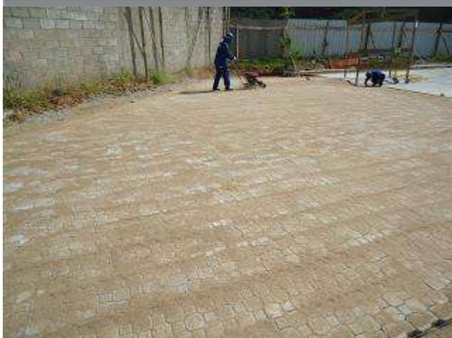
e. Compactar o piso: Após a colocação da areia de aperto, todo o pano de piso intertravado deve, ser compactado com uma placa vibratória CM-13. Todo o conjunto deverá ser batido para que os blocos se assentem sobre o colchão de areia e as juntas entre um bloquete e outro também se acertem.
