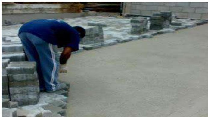
d. Salgar o Piso: Após o assentamento dos blocos, deverá ser salpicado areia sobre todo o piso assentado, a mesma deverá ser espalhada sobre toda a superfície do piso assentado. A areia deverá penetrar por todas as juntas que existem entre um bloquete e outro, dando, assim estabilidade ao conjunto.
