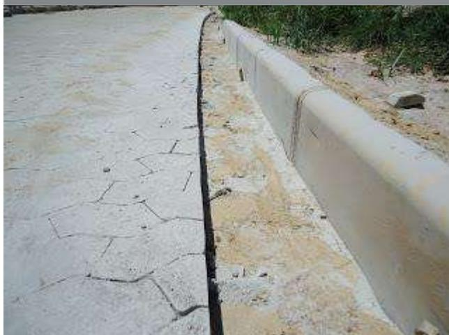
g. Varrição e limpeza: Após o terminado do assentamento e compactação e arremates deverá ser feito uma varrição do excesso de areia e a retirada dos pedaços de piso e paletes não utilizados.
